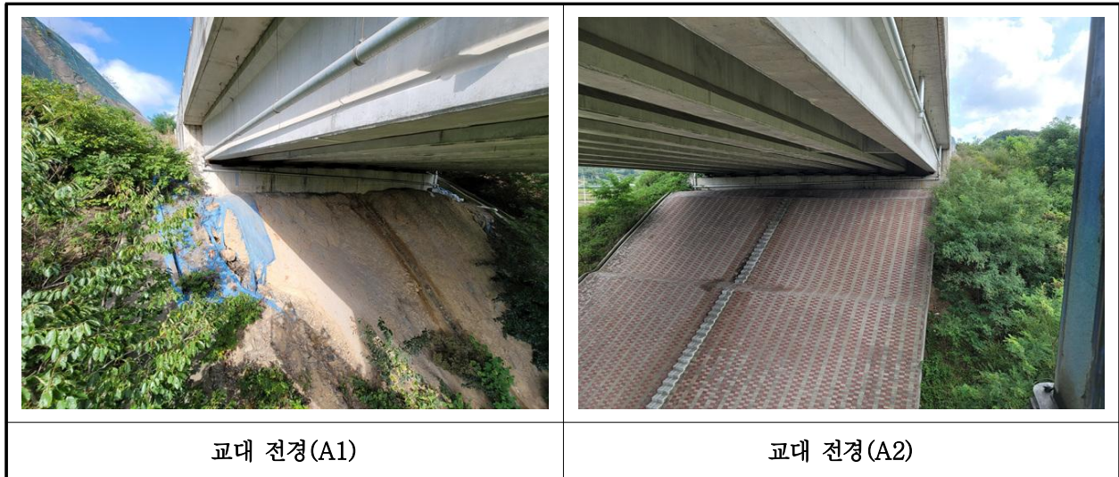
【사진 26.3.35】 교대 전경
