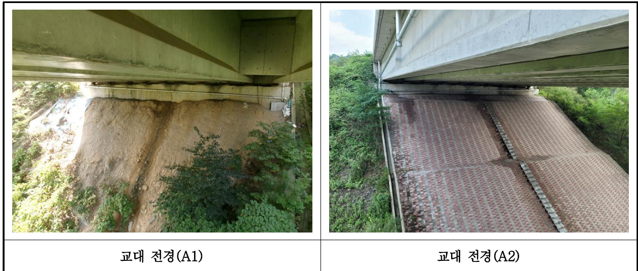
【사진 26.3.8】 교대 전경
