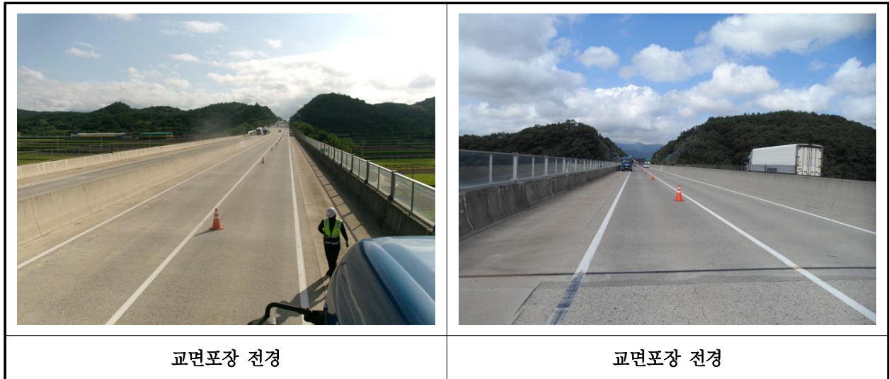
【사진 26.3.47】 교면포장 전경
