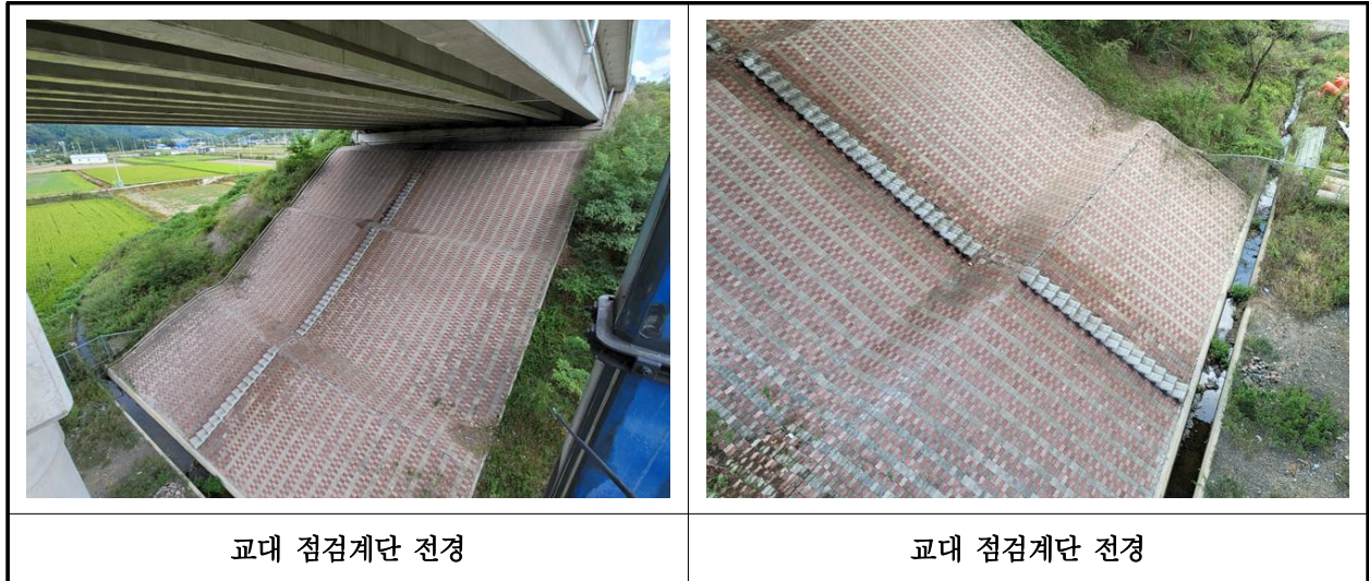
【사진 26.3.54】 교량 점검시설 전경
