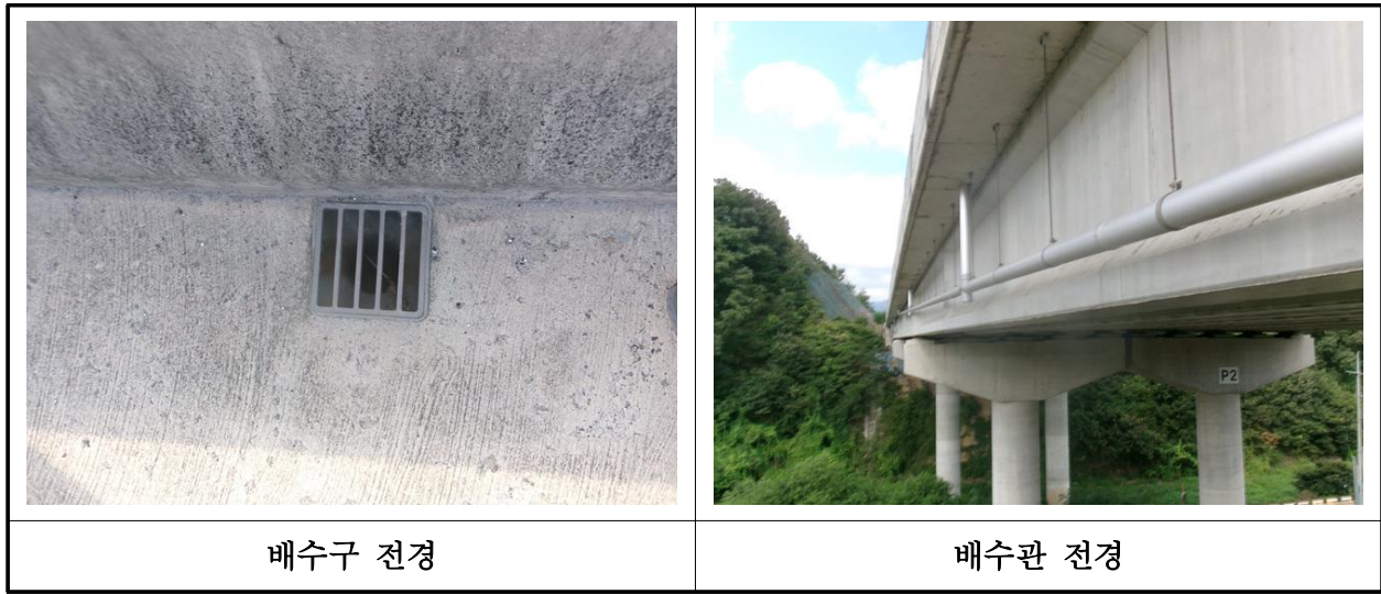
【사진 26.3.50】 배수시설 전경
