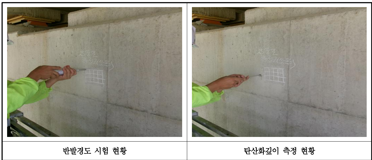
【사진 26.4.1】 콘크리트 내구성조사 현황
