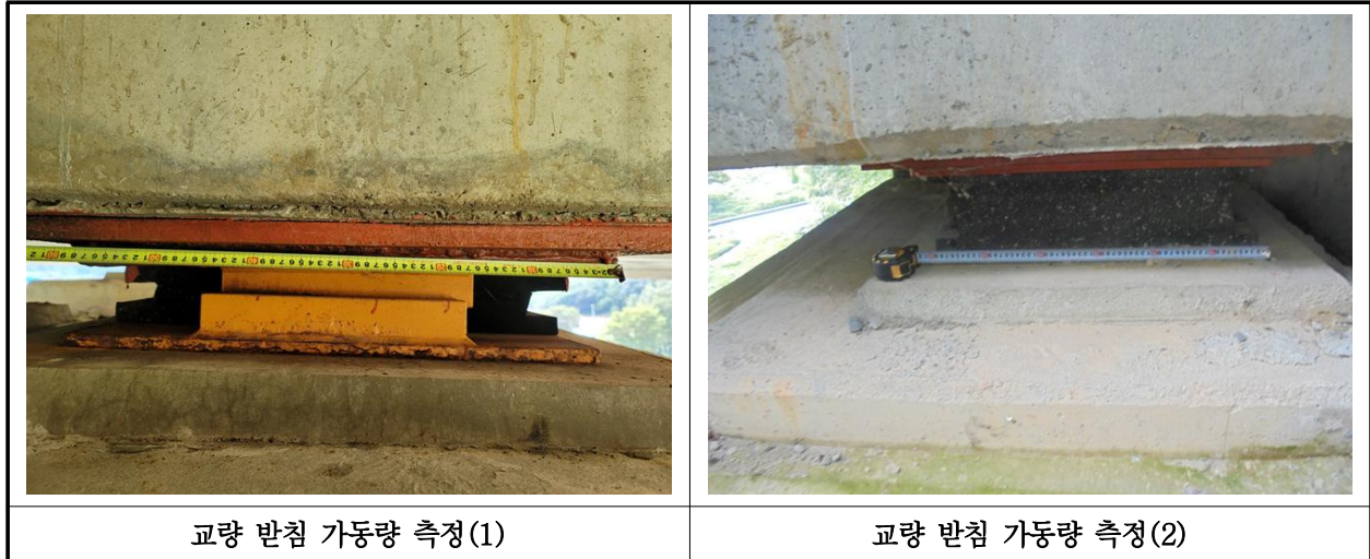
【사진 26.3.16】 교량반침 이동량 측정
