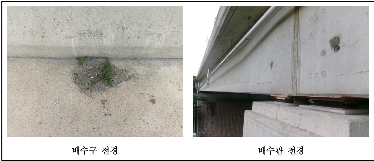
【사진 26.3.22】 배수시설 전경
