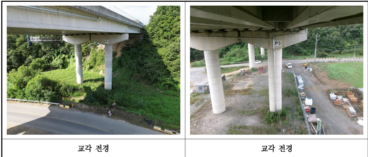
【사진 26.3.10】 교각 전경
