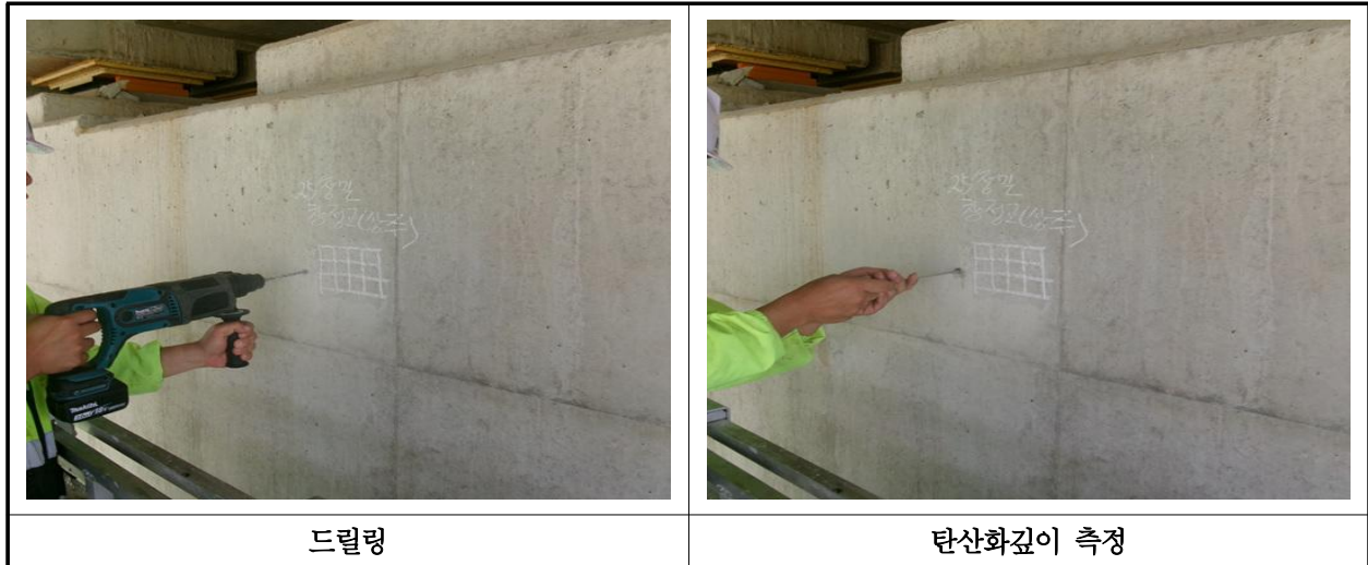
【사진 26.4.3】 탄산화 깊이 측정 현장사진
