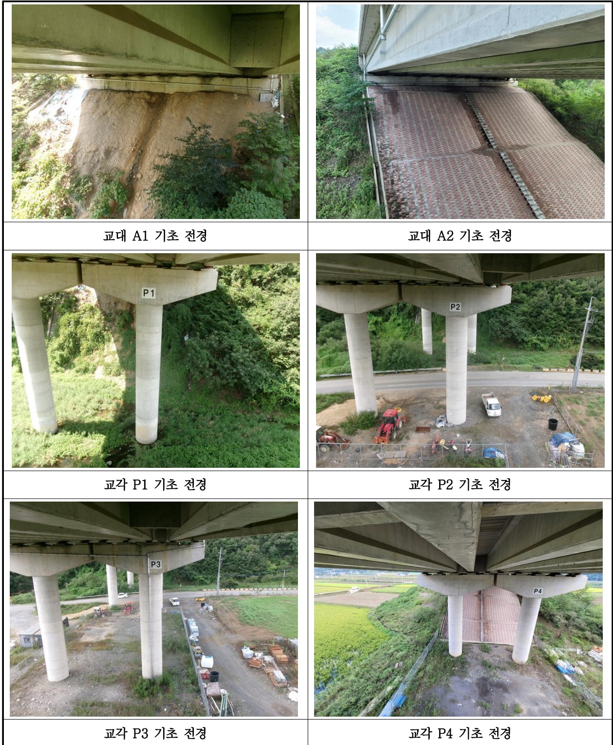
【사진 26.3.12】 기초 전경
