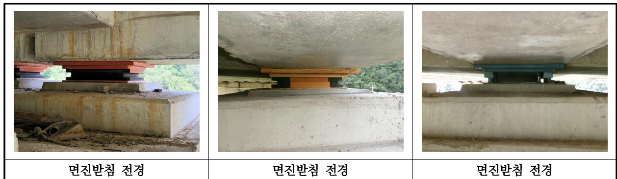
【사진 26.3.13】 교량받침 전경
