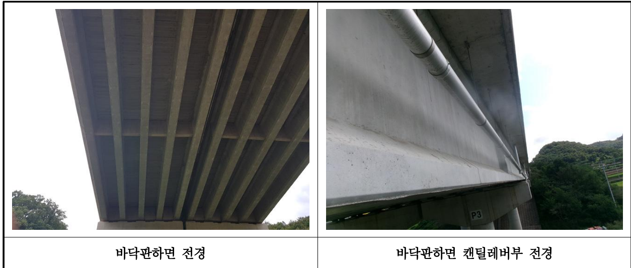
【사진 26.3.29】 바닥판하면 전경
