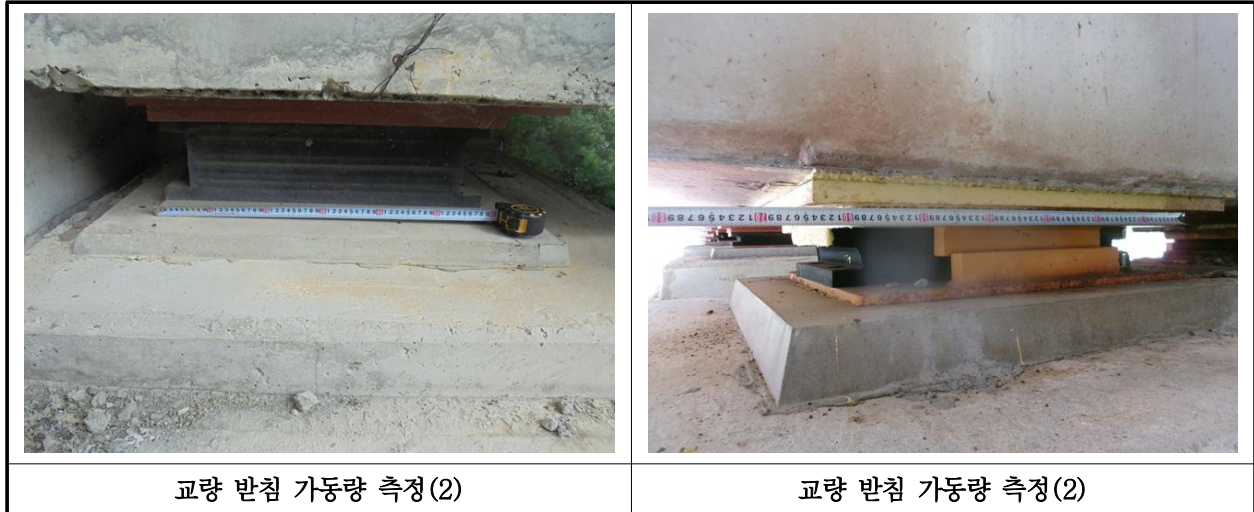
【사진 26.3.43】 교량받침 이동량 측정
