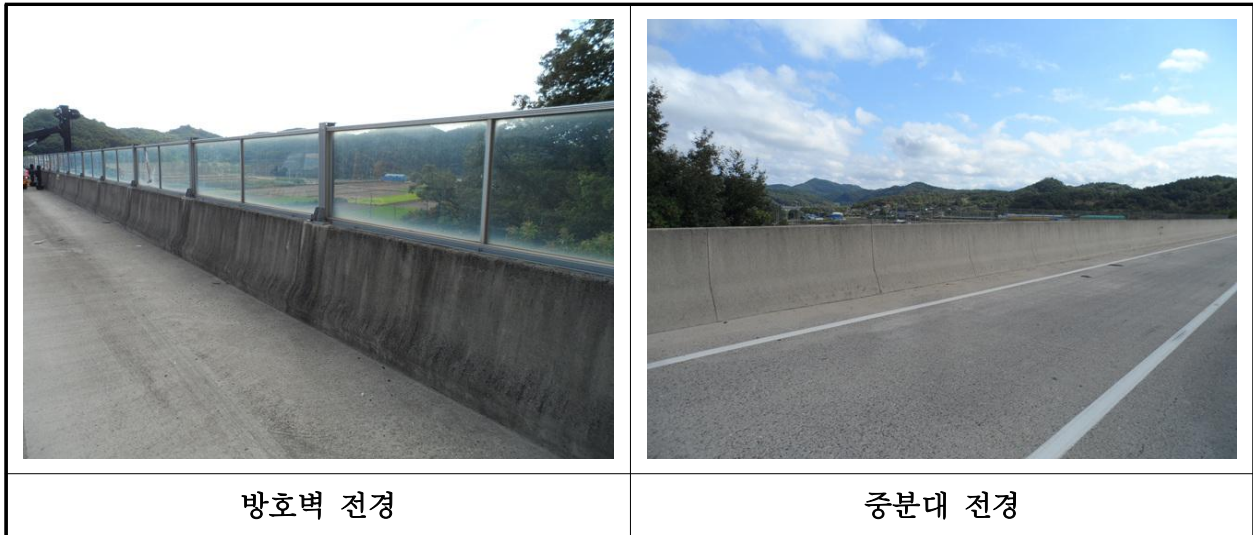
【사진 26.3.52】 방호벽 및 중분대 전경
