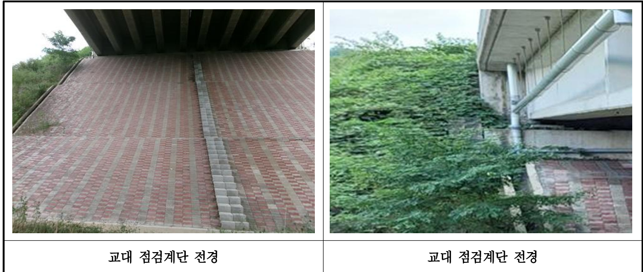
【사진 26.3.26】 교량 점검시설 전경
