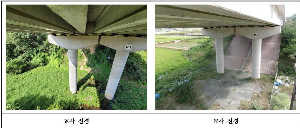
【사진 26.3.37】 교각 전경
