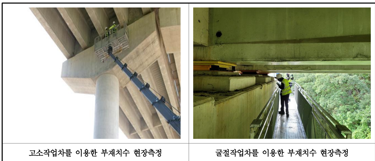
【사진 26.2.1】 부재 현장측정 전경
