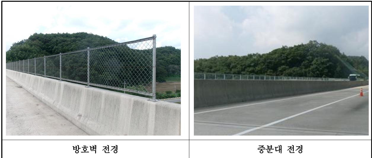
【사진 26.3.24】 방호벽 및 중분대 전경
