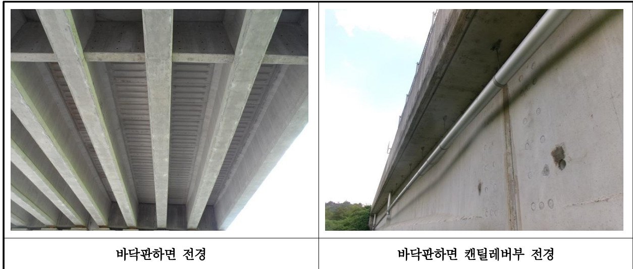
【사진 26.3.2】 바닥판하면 전경
