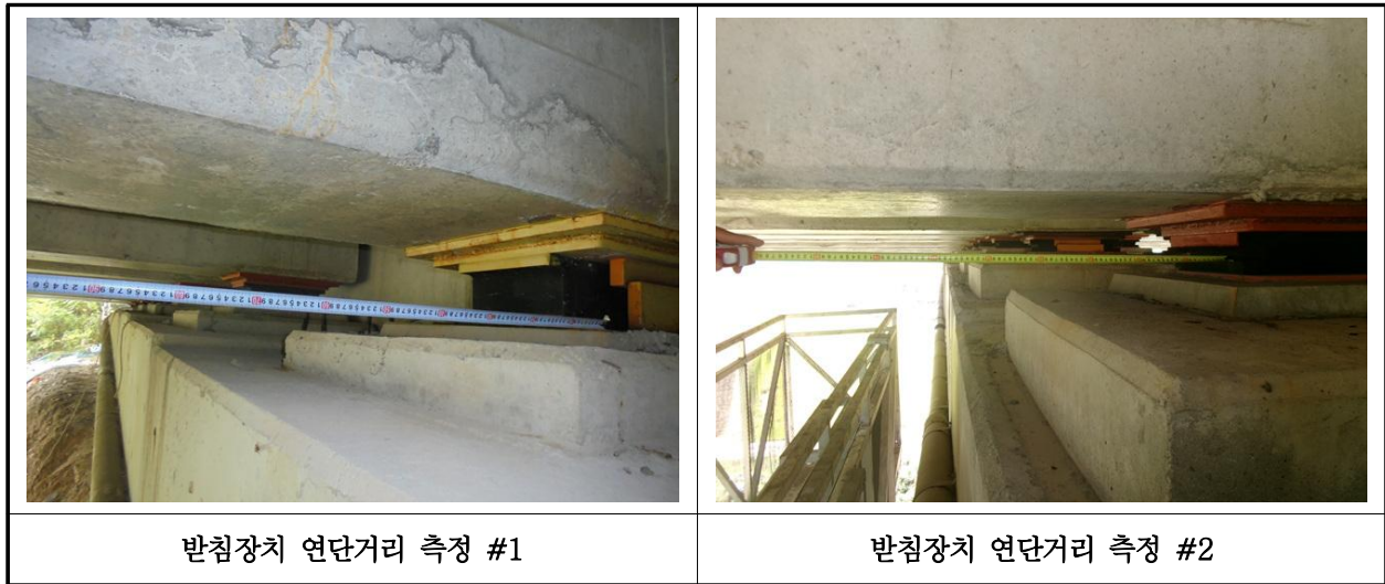
【사진 26.3.15】교량받침장치 연단거리측정
