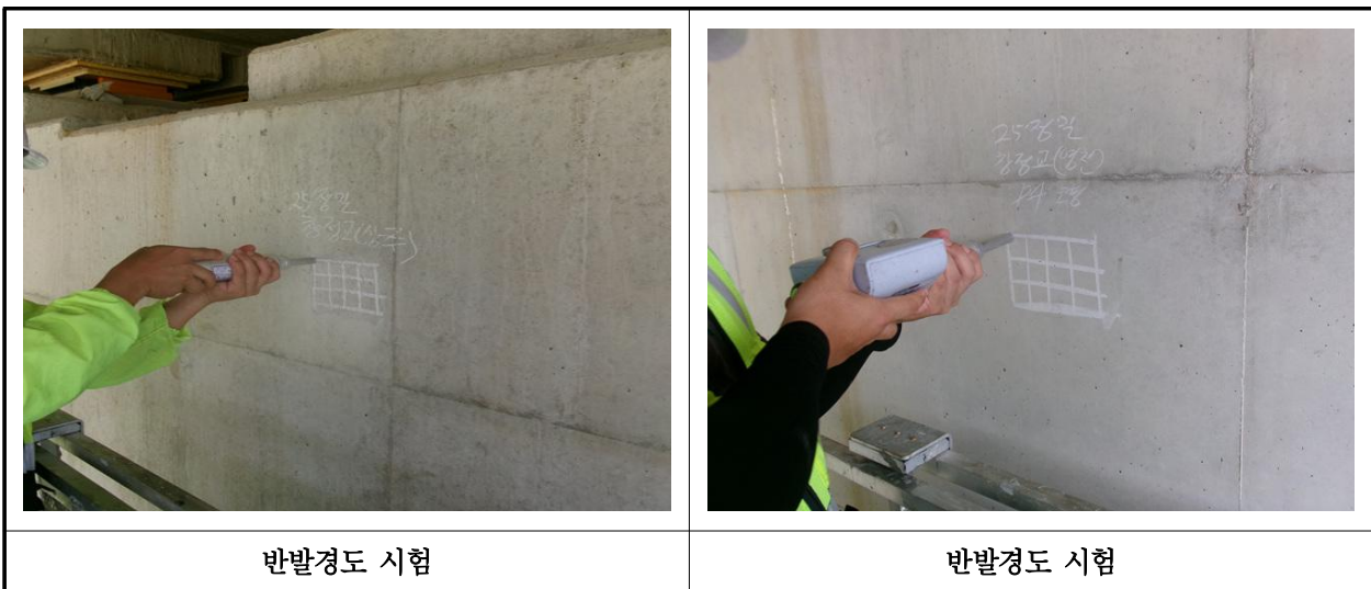
【사진 26.4.2】 반발경도시험 현장사진
